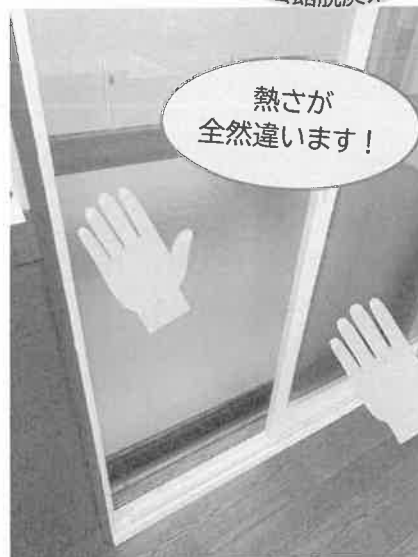
↑ 導入した断熱窓 (既存の窓に内窓を設置)
